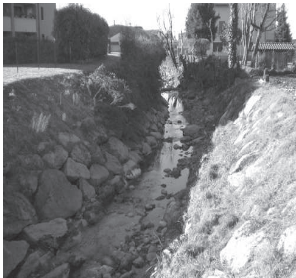
Vista dell'alveo (sulla sponda sinistra lo spazio dove sarà realizzato il percorso ciclopedonale).
